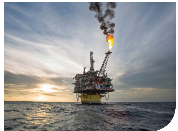
Esta plataforma de gas natural en el Golfo de México ilustra parte de la infraestructura a riesgo de tormentas costeras.
